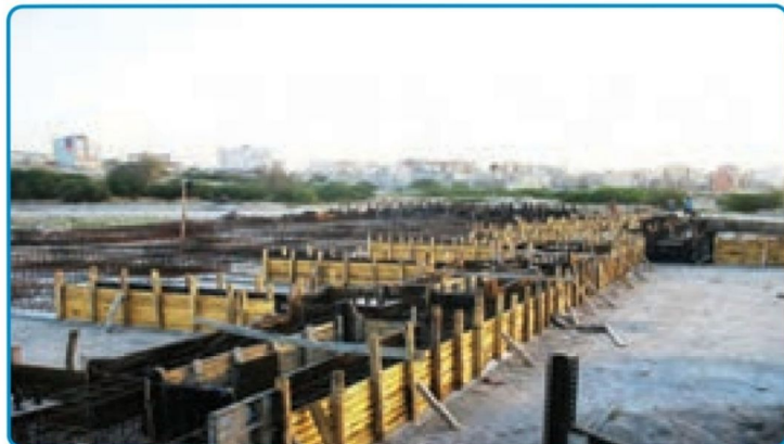
شکل ۳-۲۷- قالب چوبی برای اجرای پی
