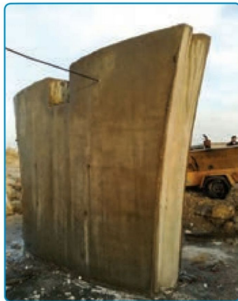
شکل ۳-۴۲- قالب برداری
