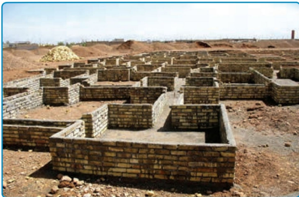
شکل ۳-۱۵- استفاده از قالب آجری برای اجرای پی
