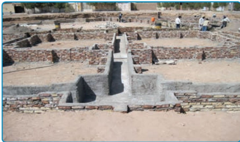
شکل ۲۹-۳- قالب آجری برای اجرای پی
