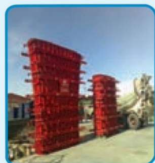
شکل ۳-۱۷- استفاده از قالب فلزی برای اجرای پایه پل
