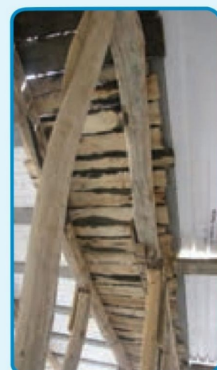
شکل ۳-۱۶- استفاده از قالب چوبی برای اجرای تیر بتنی
