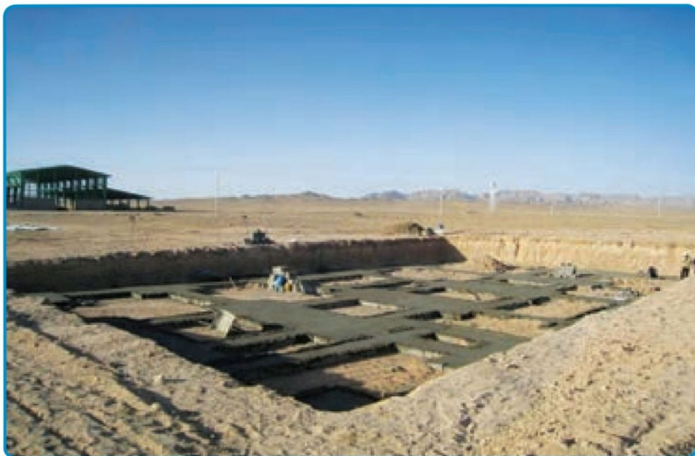
شکل ۳-۶- گودبرداری در زمین‌های نامحدود
