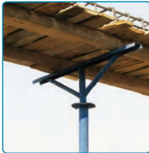
شکل ۳-۲۱- استفاده از شمع‌های فلزی جهت نگهداری قالب‌ها
