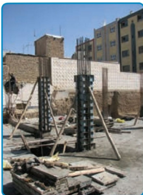
شکل ۳۲-۳- قالب فلزی برای ستون بتنی با مقطع چهارگوش
