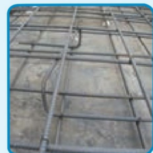
شکل ۵۵-۳- استفاده از خرک در میلگرد گذاری دال
