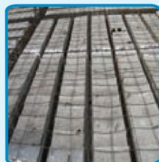
شکل ۲-۲۸- سقف تیرچه و بلوک
