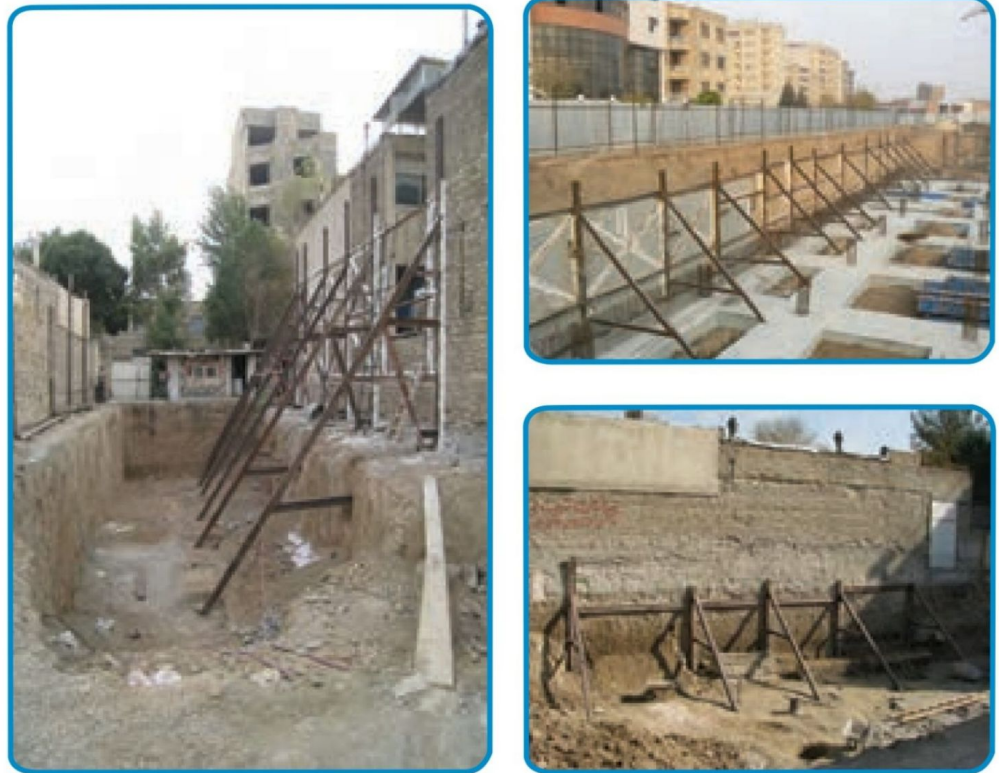
شکل ۳-۴- گودبرداری در زمین‌های محدود در تصاویر بالا اجرای سازه‌های نگهبان برای محافظت از ریزش ساختمان‌های مجاور نشان داده شده است
