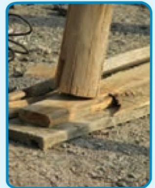
شکل ۳-۲۵- استفاده از گُوه جهت تنظیم ارتفاع
