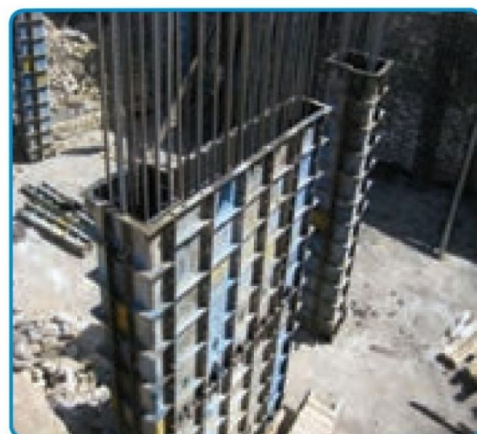
شکل ۳-۳۵- قالب فلزی برای اجرای دیوار بتنی
