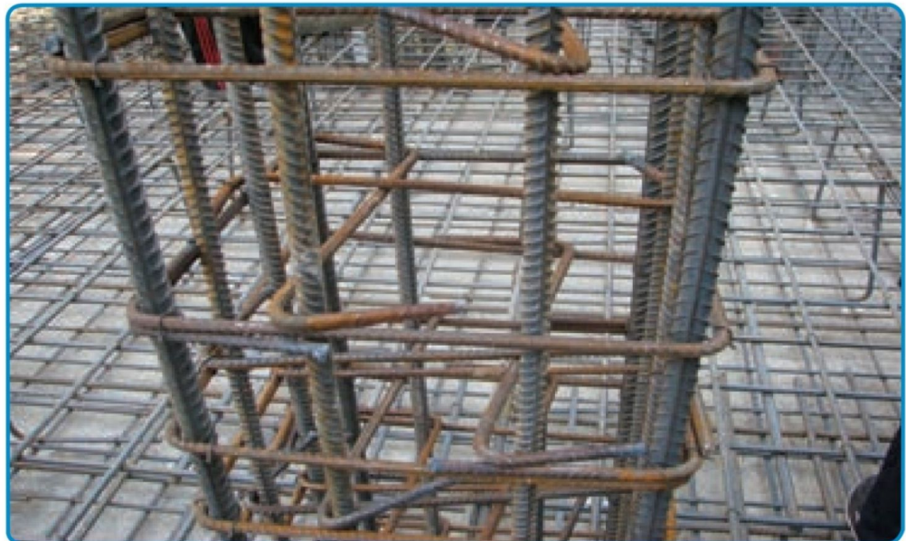
شکل ۵۰-۳- کاربرد سنجاقک در میلگرد گذاری ستون
