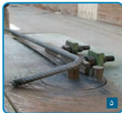
شکل ۳-۶۴ خم کردن میلگرد
