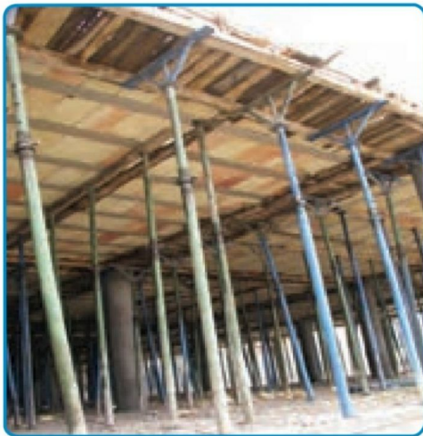
شکل ۳-۲۱- استفاده از شمع‌های فلزی جهت نگهداری قالب‌ها
