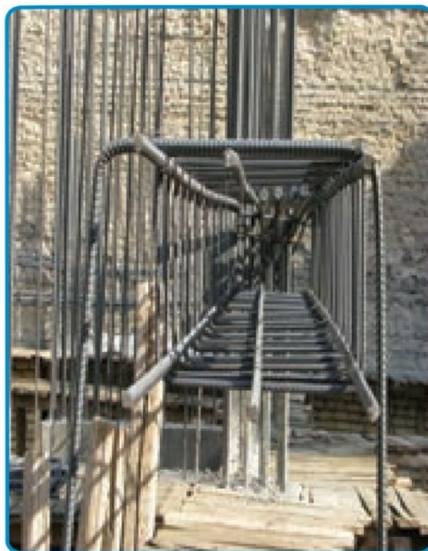
شکل ۳-۴۵- میلگرد طولی در تیر
