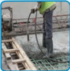
شکل ۱۴-۳- ویبراتور یا لرزاننده بتن داخل قالب
