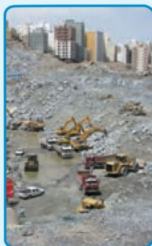
شکل ۳-۷- گودبرداری در زمین‌های نامحدود
