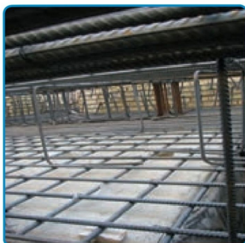
شکل ۵۳-۳- استفاده از خرک در میلگرد گذاری پی
