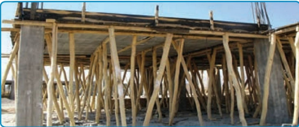
شکل ۳-۲۴- استفاده از شمع‌های چوبی جهت نگهداری قالب‌ها
